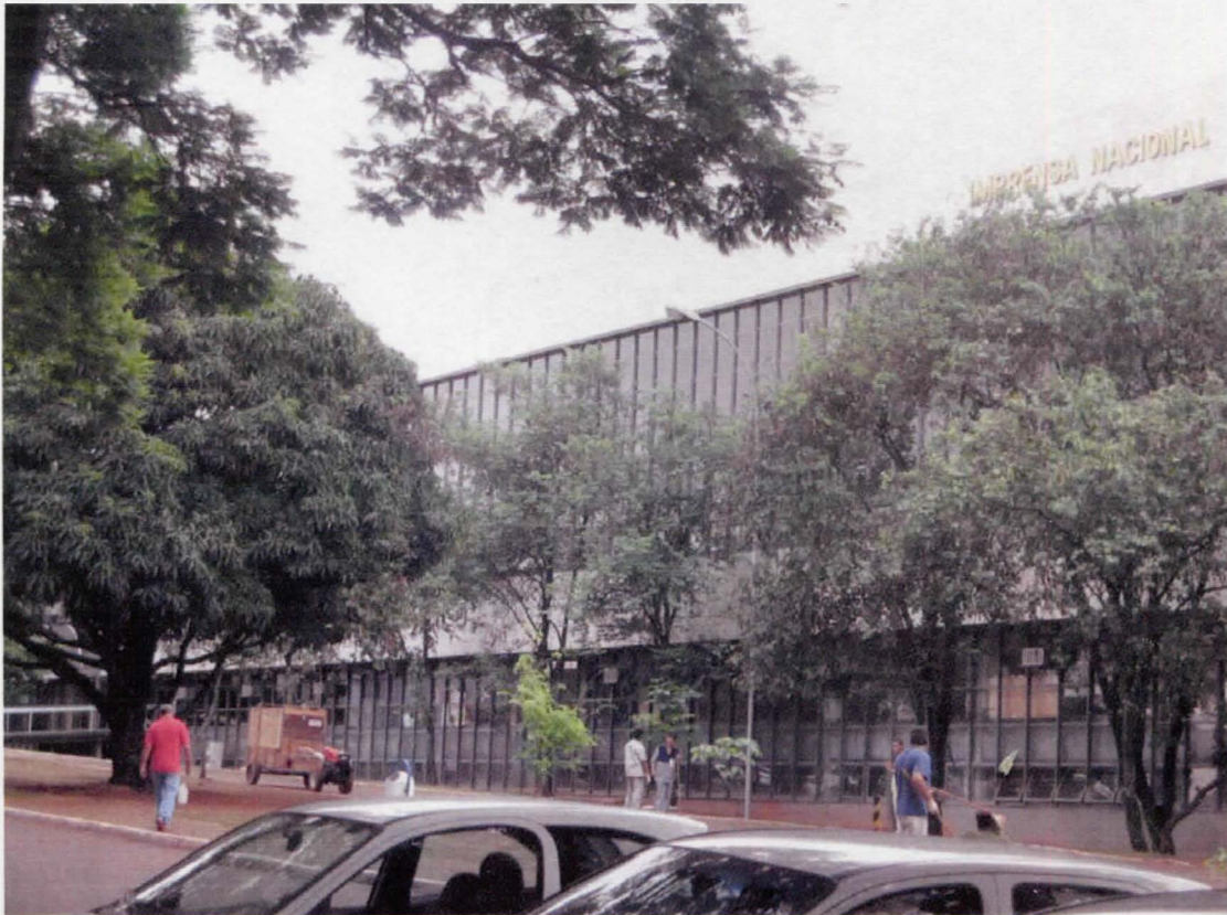
Vista externa do prédio da Imprensa Nacional em Brasília (2006).
