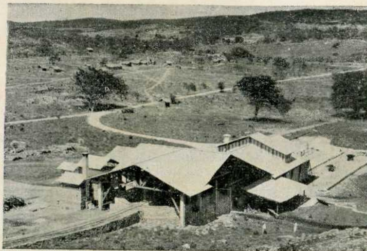
5 — Vista geral nordeste da usina experimental de beneficiamento de amianto da "S.A. Mineração de Amianto" em Bom Jesus de Poções, Baía.
