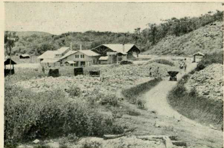
3 — Instalações da mina de Bom Jesús de Poções, Baía, da "S.A. Mineração de Amianto", vendo-se a via de transporte do minério, a balança e a usina de beneficiamento.
