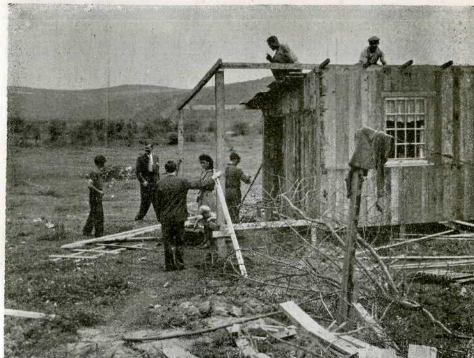
Construção de casas provisórias em terreno comprado à prestação por deslocados.
