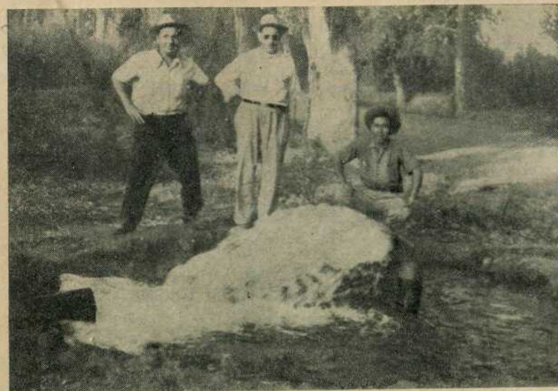
Poço artesiano de 97 metros de profundidade, jorrando 1.500 m 3 d'água por dia. Desses poços existem de 500 em 500 metros ao longo dos canais de irrigação, a fim de aumentar o volume d'água. Fotografia obtida nos arredores de Mendoza, Argentina. Poços artesianos são recursos possíveis aqui, em nosso País, para irrigação dos pomares e hortas.
