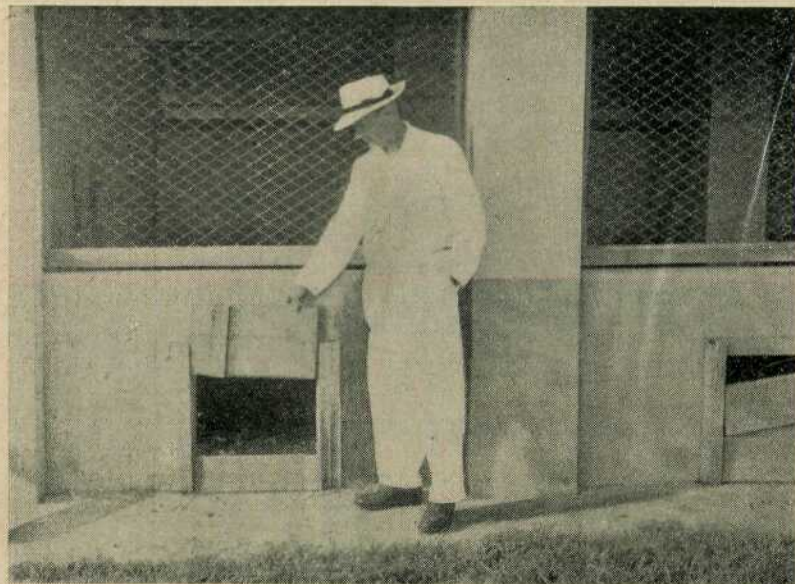
Portinhola para saída de marrecos dos abrigos. A tábua inferior é mantida para segurar a cama. A superior pode ser colocada à noite para as aves dormirem fechadas.
